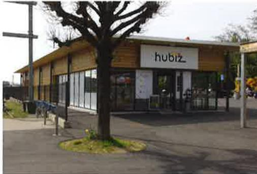
compose d'un quadrilatère d'un étage, tout en bois à l'exception de colonnes métalliques extérieures en métal. Long de 40 mètres, large de 10, prolongeant la gare à l'ouest, le bâtiment, qui se situe à 10 mètres des rails auxquelles il tourne le dos, s'ouvre d'un côté sur la gare elle-même et, de l'autre, sur la place récemment réaménagée. Il offre une surface de vente de 200m<sup>2</sup> et un arrière-magasin de 140m<sup>2</sup>.
