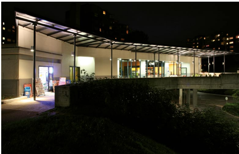
Photos: Processus Immobilier SA
